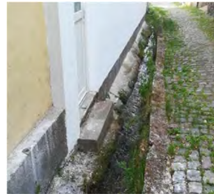
Abbildung 82 Boppard, Burdenbach als Rinne neben Gebäuden, (Quelle: Hochschule Koblenz/Kaspar 2020)
