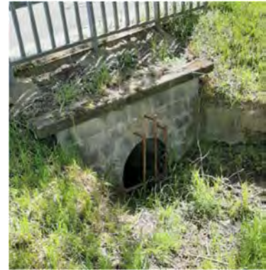
Abbildung 85 St. Goar, Abfluss des Lohbachs unter dem Rheinbalkon (Quelle: Hochschule Koblenz/Kimmel 2020), Einlauf des Lohbachs in die Verrohrung, Rechen, der zu Verkläuerung neigt, Einlaufquerschnitt evtl. zu gering dimensioniert (Quelle: Hochschule Koblenz/Gelhard 2020)
