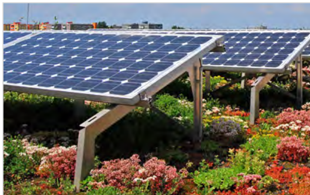
Abbildung 117 Kombination von Fotovoltaik und Gründach (links, Quelle: ZinCo GmbH) - mögliche Lösung für das Parkdeck in Boppard (rechts, Quelle: Hochschule Koblenz/Kirchner 2020)
