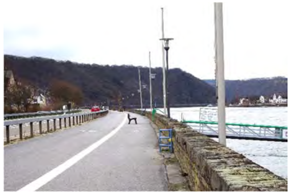
Abbildung 111 Radweg linksrheinisch im Bereich Bad Salzig (Quelle: Hochschule Koblenz/Kirchner 2020)
