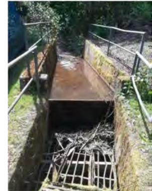
Abbildung 80 Boppard: Einmündung des Bruder-Michels-Bachs in den Rhein. Betonierete Sohle, erschwerter Zugang. (Quelle: Hochschule Koblenz/Kimmel 2020), Fraubach, maroder Rechen vor verrohrtem Abschnitt (Quelle: Hochschule Koblenz/Kaspar 2020)
